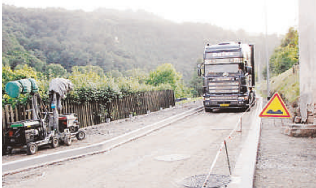
Des chauffeurs de poids lourds s'inquiètent du manque de visibilité dans le rétrécissement à la sortie de Lièpvre. (Photo DNA)
